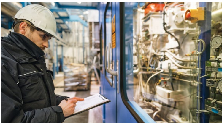
Powerhalle: Wartungskontrolle am Gasgenerator
