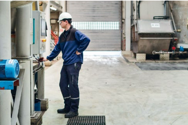
Kontrolle der Produktionsparameter der Nickelnitratanlage
